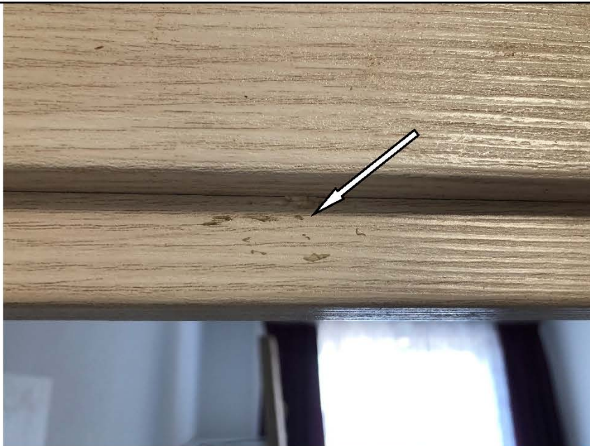
Фото №32. Загрязнения на коробке деревянного дверного блока в детской в квартире.
