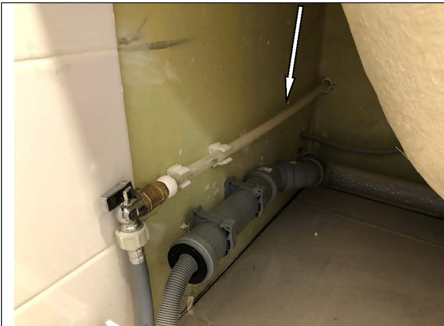
Фото №82. Частично не хватает настенной керамической плитки в ванной комнате в квартире.
