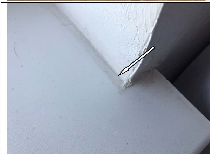
Фото №47. Загрязнения на подоконной доске в детской в квартире.
