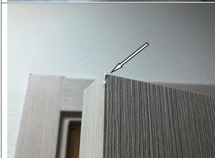
Фото №39. Скол на полотне деревянного дверного блока в ванной комнате в квартире.
