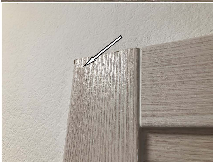
Фото №15. Загрязнения на наличнике деревянного дверного блока в спальне в квартире.
