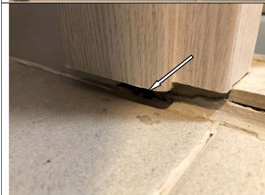
Фото №86. Наличник деревянного дверного блока не достает до напольного покрытия в ванной комнате в квартире.
