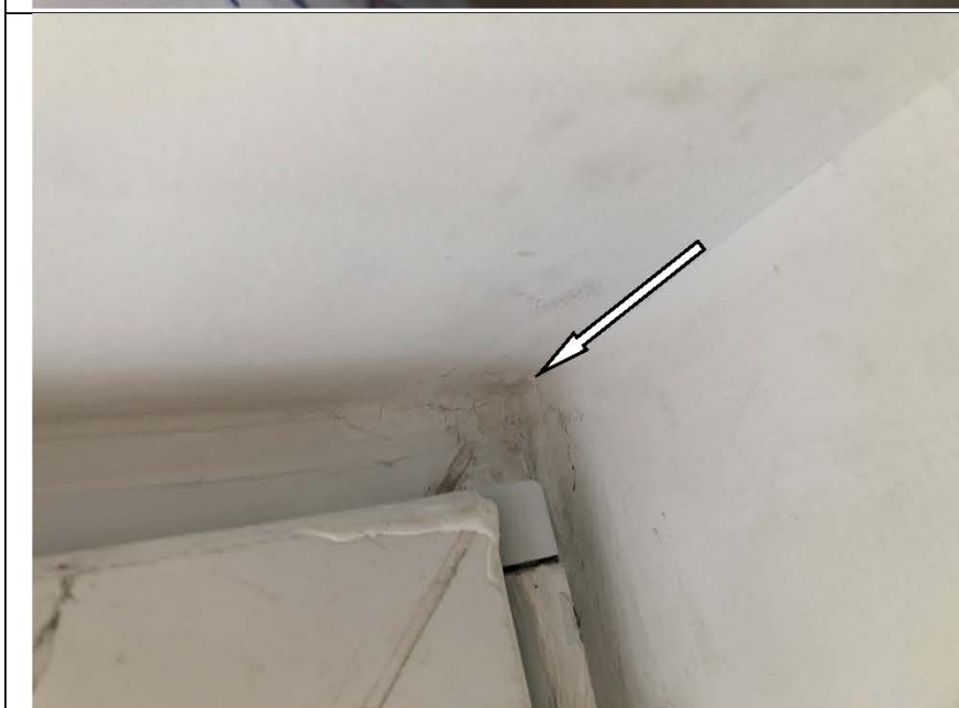
Фото №63. Инфильтрация оконного блока ПВХ в детской в квартире.
