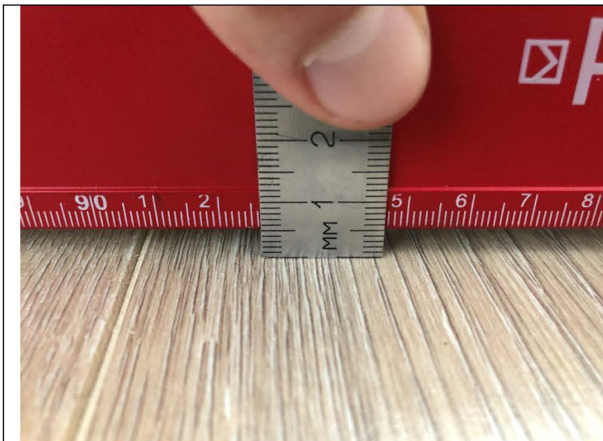
Фото №70. Измерение напольного покрытия в спальне в квартире.
