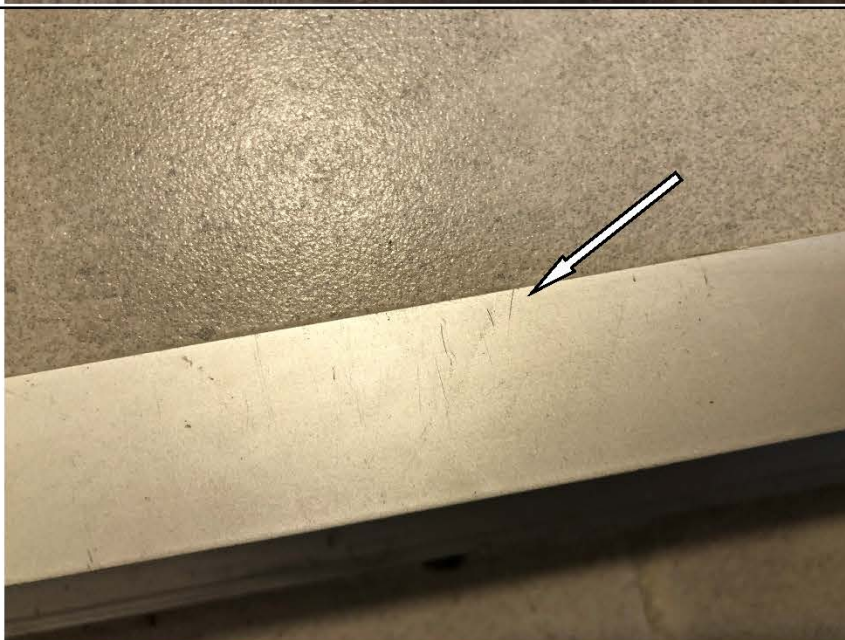
Фото №41. Загрязнения на напольном металлическом порожке в санузле в квартире.
