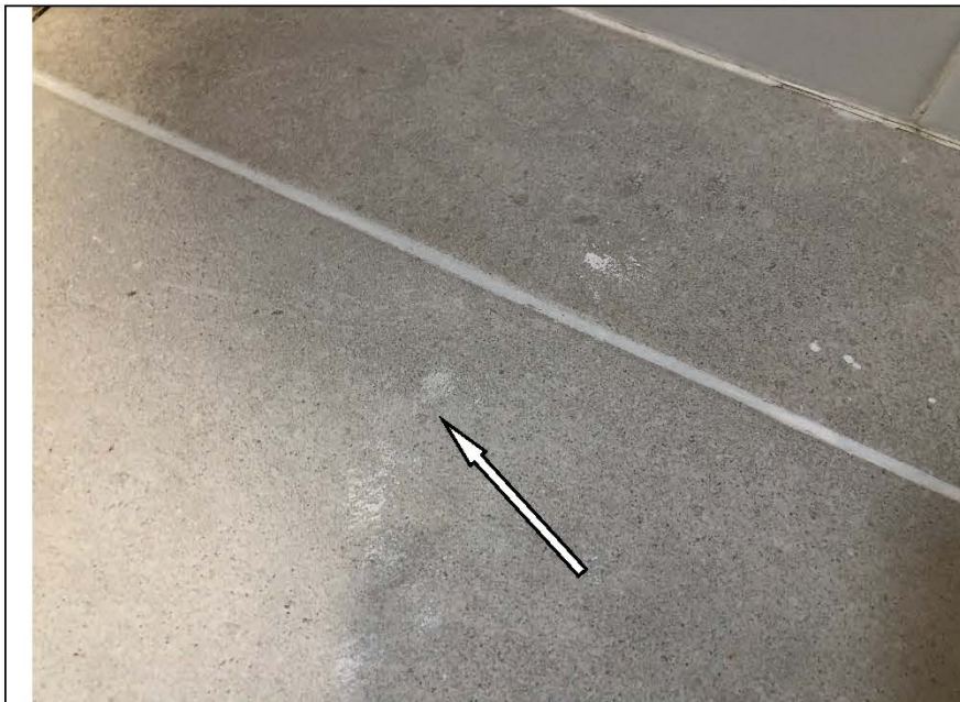
Фото №22. Неровный шов и загрязнения напольной керамической плитки в санузле в квартире.
