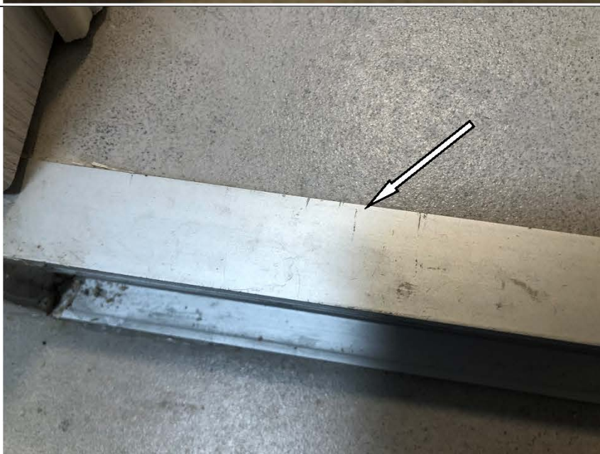
Фото №42. Царапины на напольном металлическом порожке в ванной комнате в квартире.
