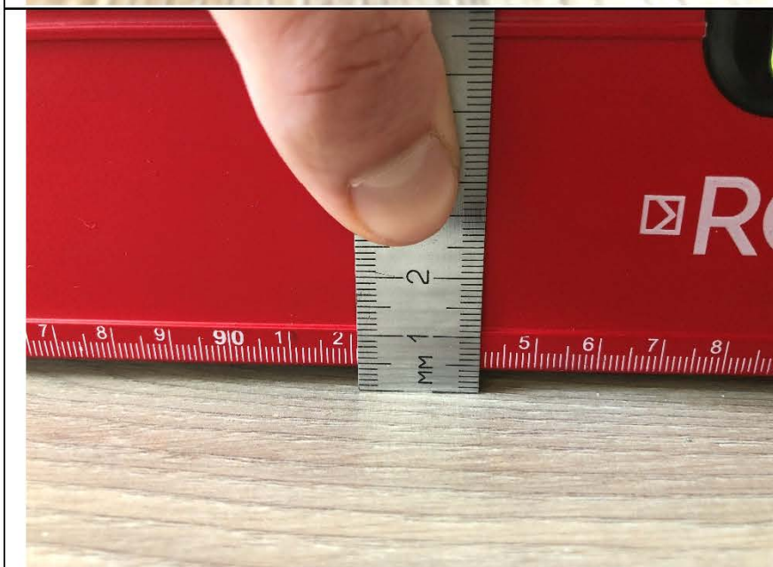
Фото №71. Измерение напольного покрытия в кухне в квартире.
