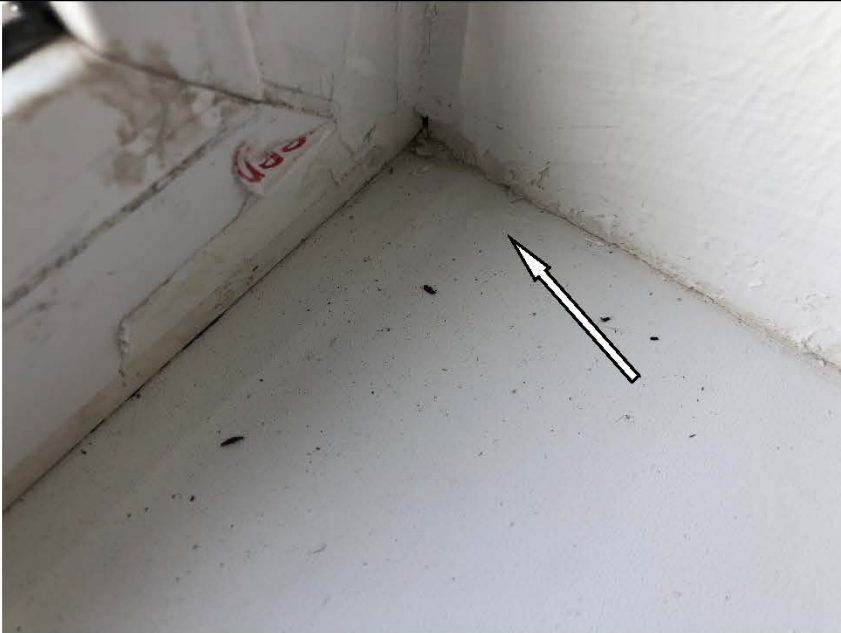
Фото №49. Загрязнения на подоконной доске в кухне в квартире.
