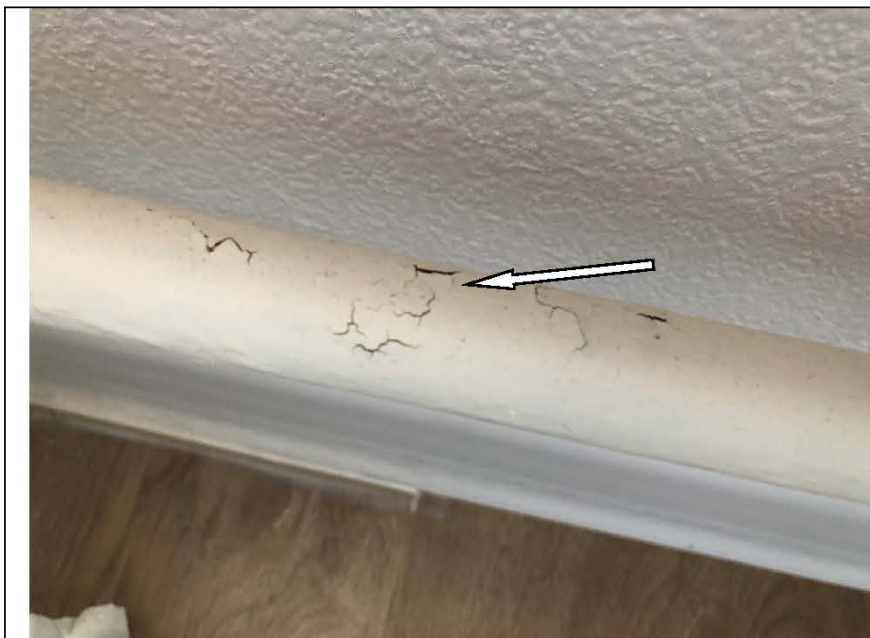
Фото №67. Неровности, сколы на окрашенных трубах отопления в спальне в квартире.
