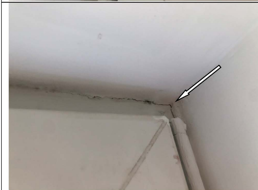
Фото №65. Инfiltrация оконного блока ПВХ в кухне в квартире.
