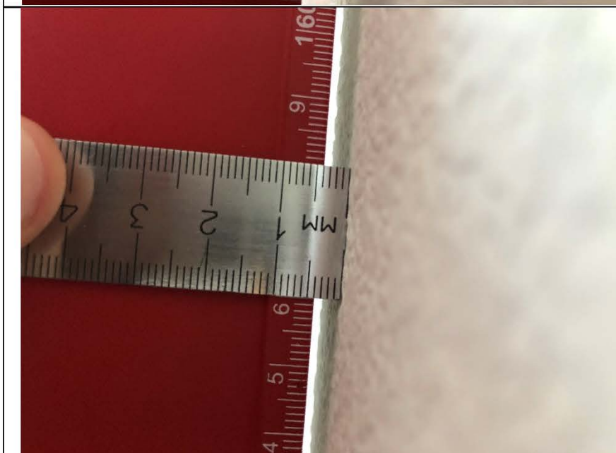
Фото №9. Измерение уровня стен детской в квартире.
