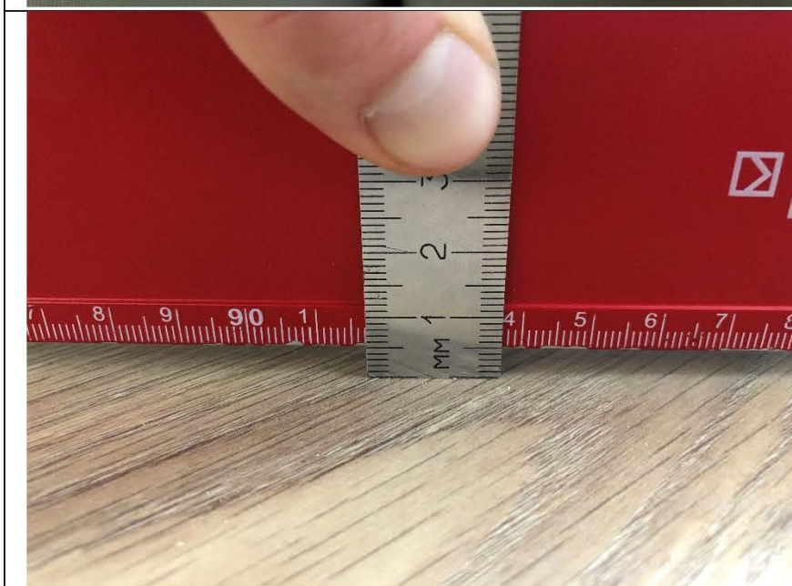
Фото №69. Измерение напольного покрытия в детской в квартире.
