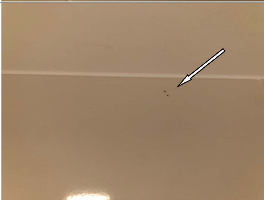
Фото №78. Загрязнения на настенной керамической плитке в ванной комнате в квартире.
