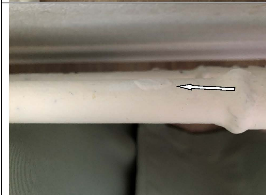
Фото №68. Неровности, сколы на окрашенных трубах отопления в кухне в квартире.
