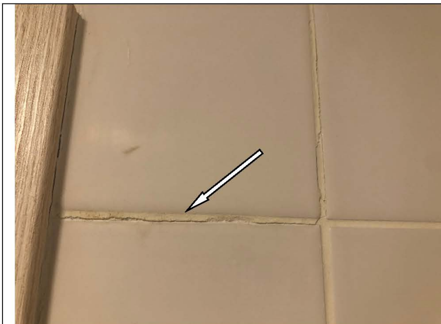
Фото №85. Неровный шов настенной керамической плитки в ванной комнате в квартире.
