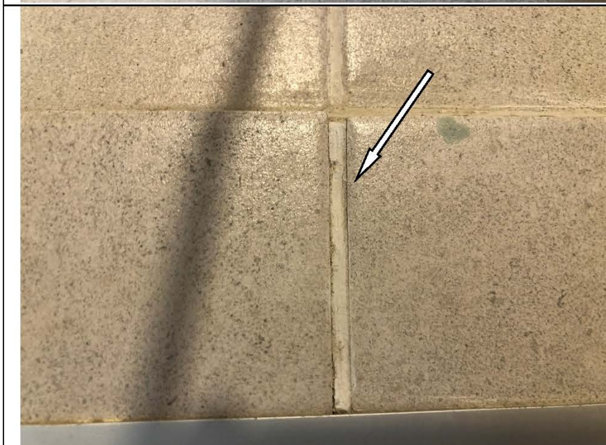
Фото №23. Неровный шов напольной керамической плитки в ванной комнате в квартире.
