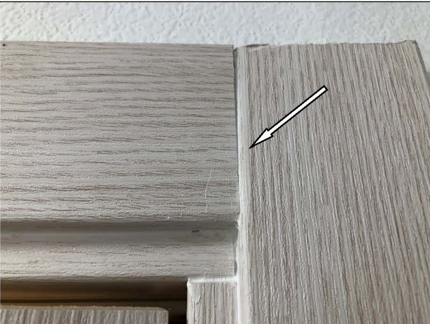
Фото №17. Загрязнения на наличнике деревянного дверного блока в ванной комнате в квартире.
