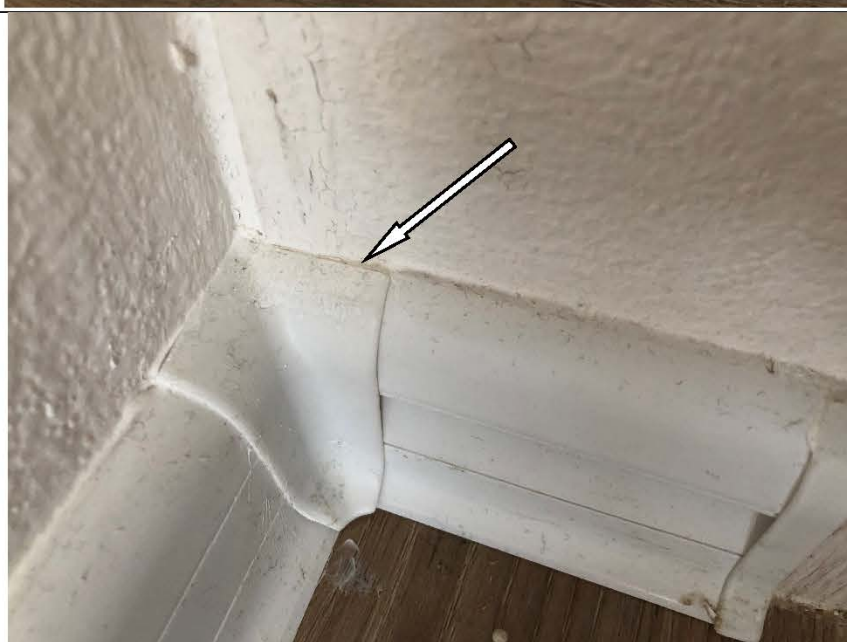
Фото №27. Загрязнения на напольном плинтусе ПВХ в спальне в квартире.
