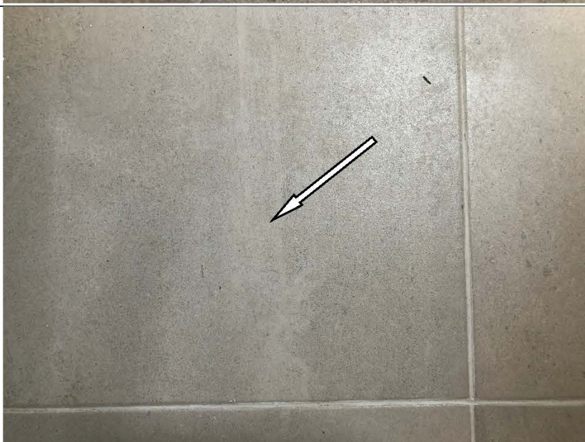
Фото №30. Загрязнения на напольной керамической плитке в ванной комнате в квартире.
