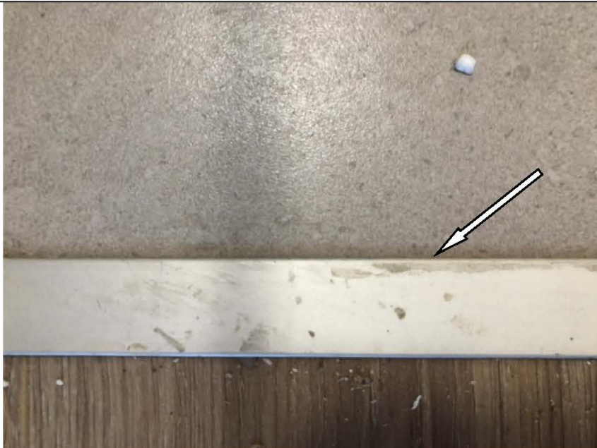
Фото №40. Загрязнения на напольном металлическом порожке в детской в квартире.
