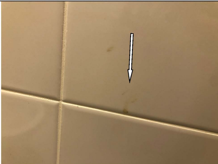
Фото №77. Загрязнения на настенной керамической плитке в санузле в квартире.
