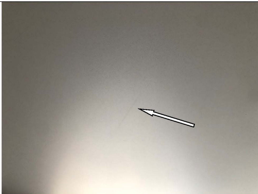
Фото №19. Загрязнения на полотне натяжного потолка в детской в квартире.
