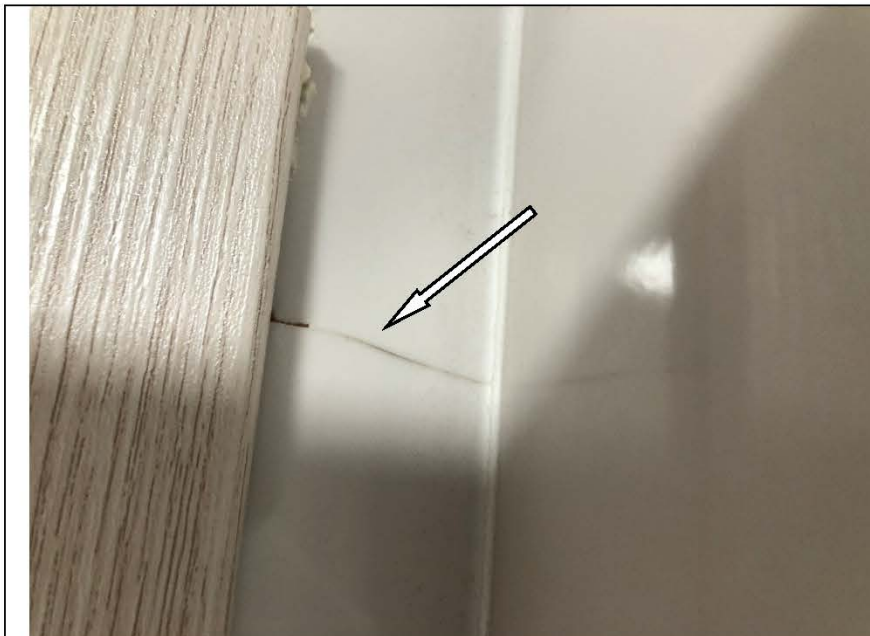
Фото №79. Трещина на настенной керамической плитке в санузле в квартире.
