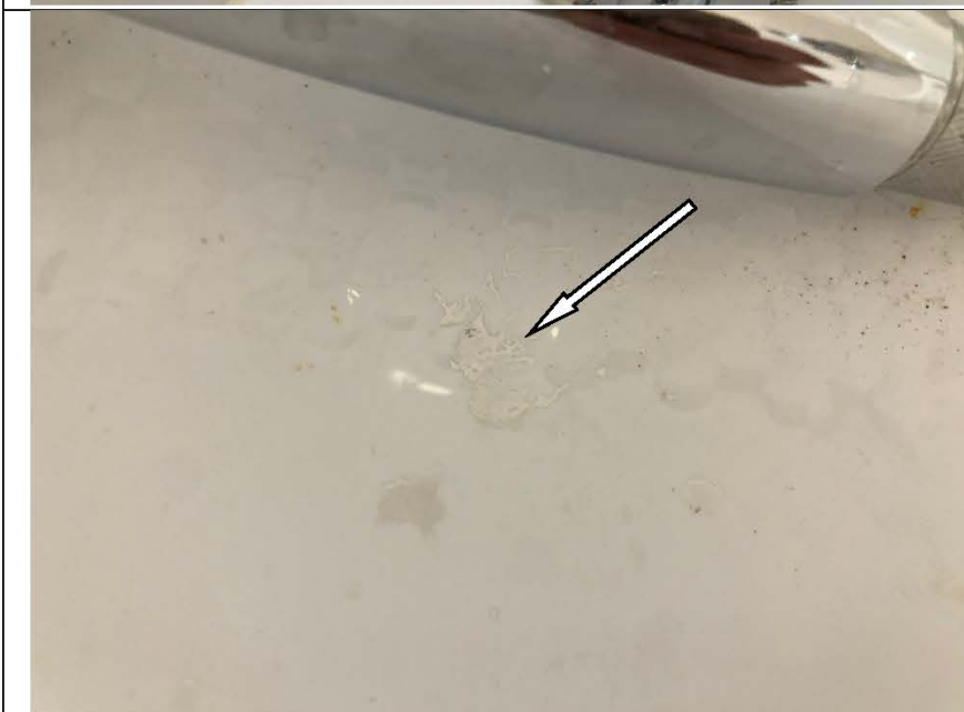
Фото №84. Загрязнения на ванной в ванной комнате в квартире.
