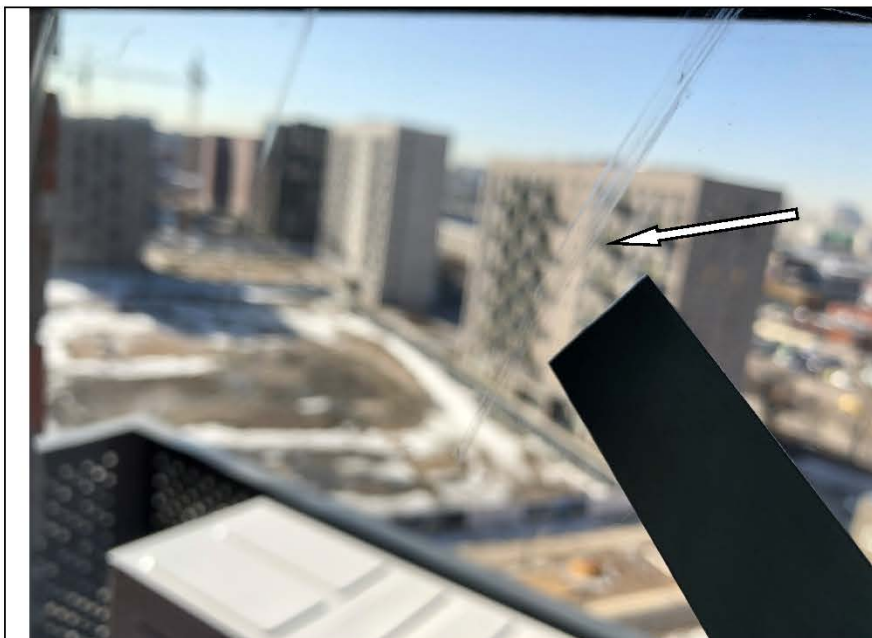
Фото №58. Царапины на стеклопакете оконного блока ПВХ в кухне в квартире.
