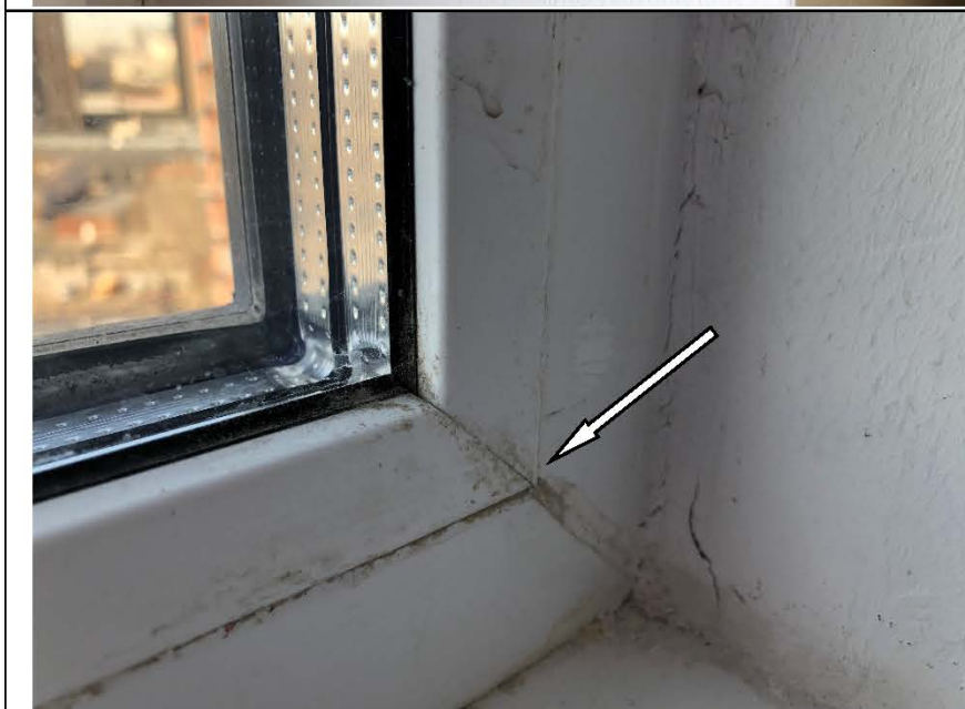
Фото №53. Загрязнения на профиле оконного блока ПВХ в детской в квартире.
