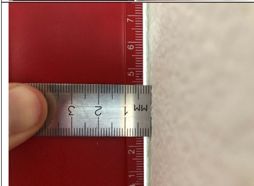
Фото №11. Измерение уровня стен кухни в квартире.
