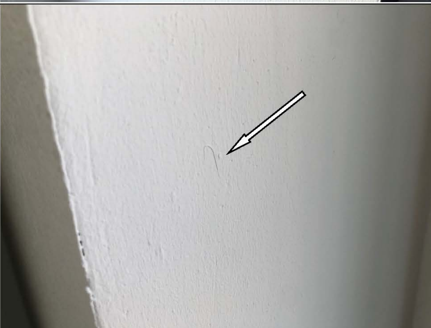
Фото №51. Неровности, сколы на окрашенных откосах оконного блока ПВХ в спальне в квартире.
