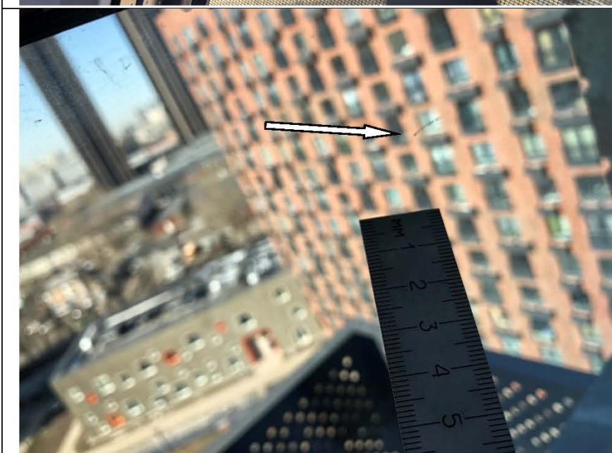
Фото №57. Царапины на стеклопакете оконного блока ПВХ в спальне в квартире.
