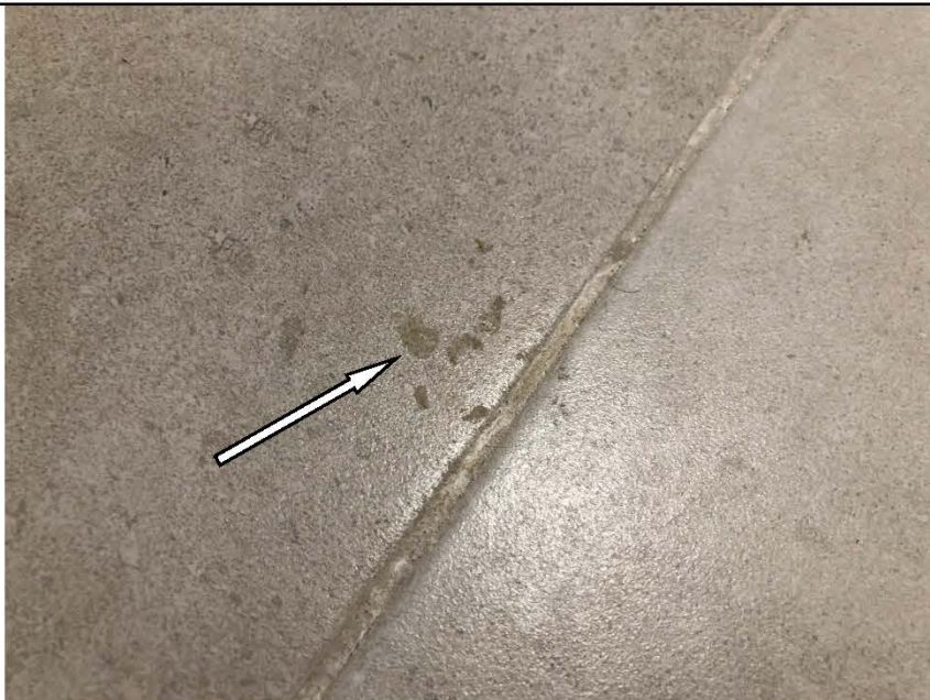
Фото №29. Загрязнения на напольной керамической плитке в коридоре в квартире.
