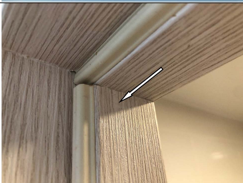
Фото №35. Загрязнения на коробке деревянного дверного блока в ванной комнате в квартире.
