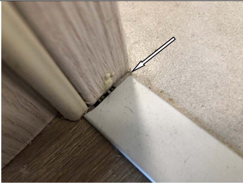
Фото №76. Коротко обрезан напольный металлический порожек в спальне в квартире.
