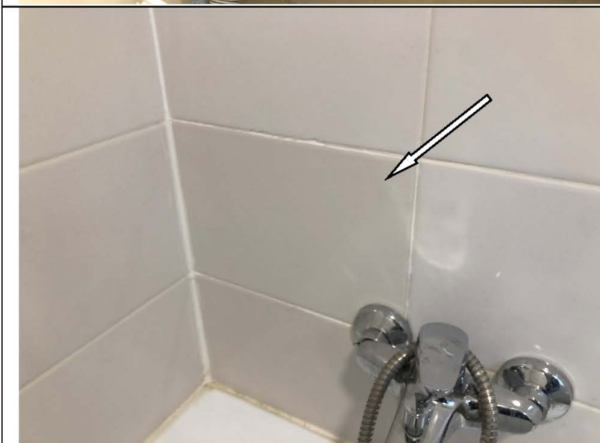
Фото №83. Разный цвет настенной керамической плитки в ванной комнате в квартире.
