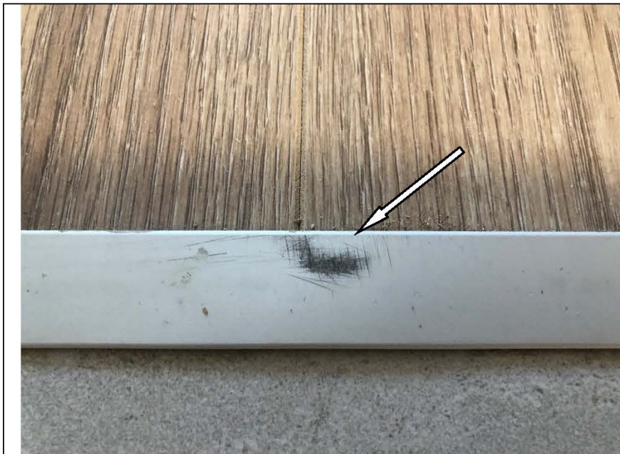
Фото №43. Царапины на напольном металлическом порожке в кухне в квартире.
