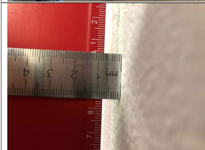
Фото №8. Измерение уровня стен коридора в квартире.
