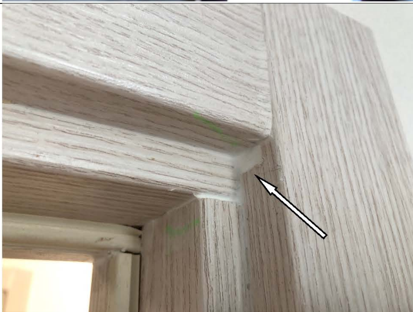
Фото №33. Загрязнения на коробке деревянного дверного блока в спальне в квартире.
