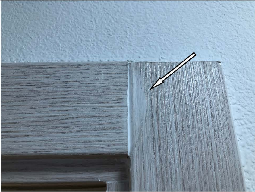
Фото №16. Загрязнения на наличнике деревянного дверного блока в санузле в квартире.
