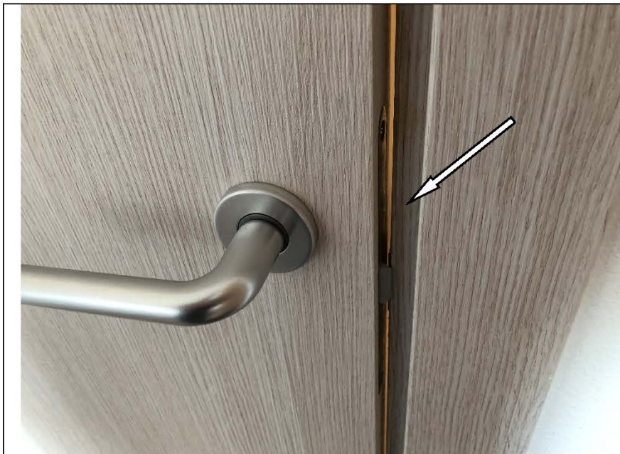
Фото №73. Дверь не закрывается свободно в спальне в квартире.
