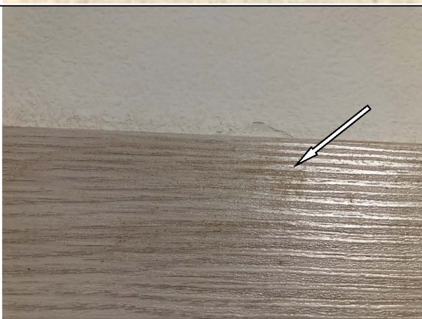
Фото №14. Загрязнения на наличнике деревянного дверного блока в детской в квартире.
