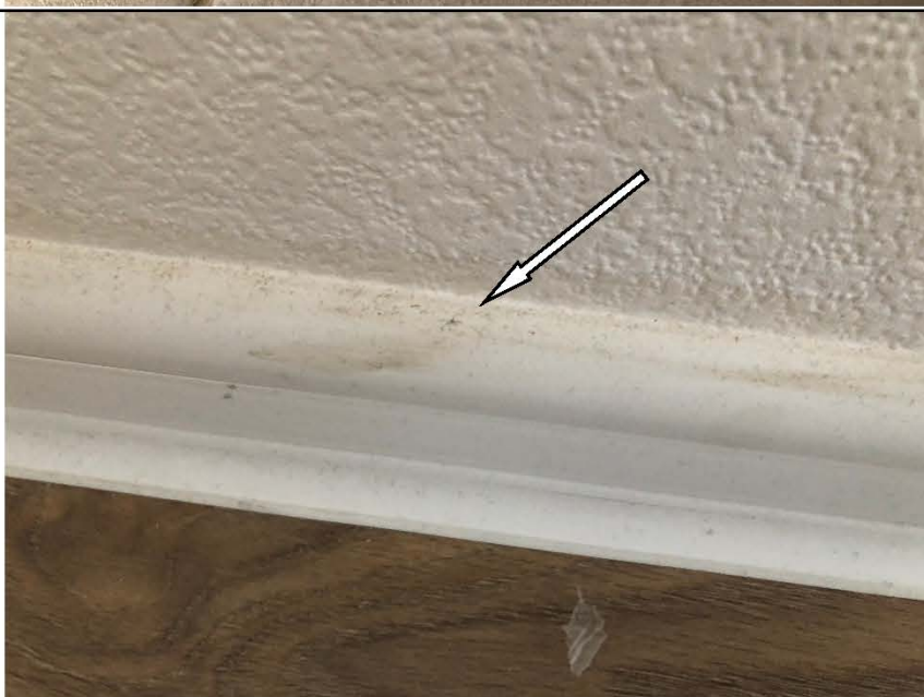
Фото №26. Загрязнения на напольном плинтусе ПВХ в детской в квартире.
