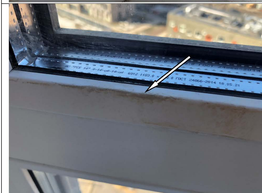
Фото №54. Загрязнения на профиле оконного блока ПВХ в спальне в квартире.
