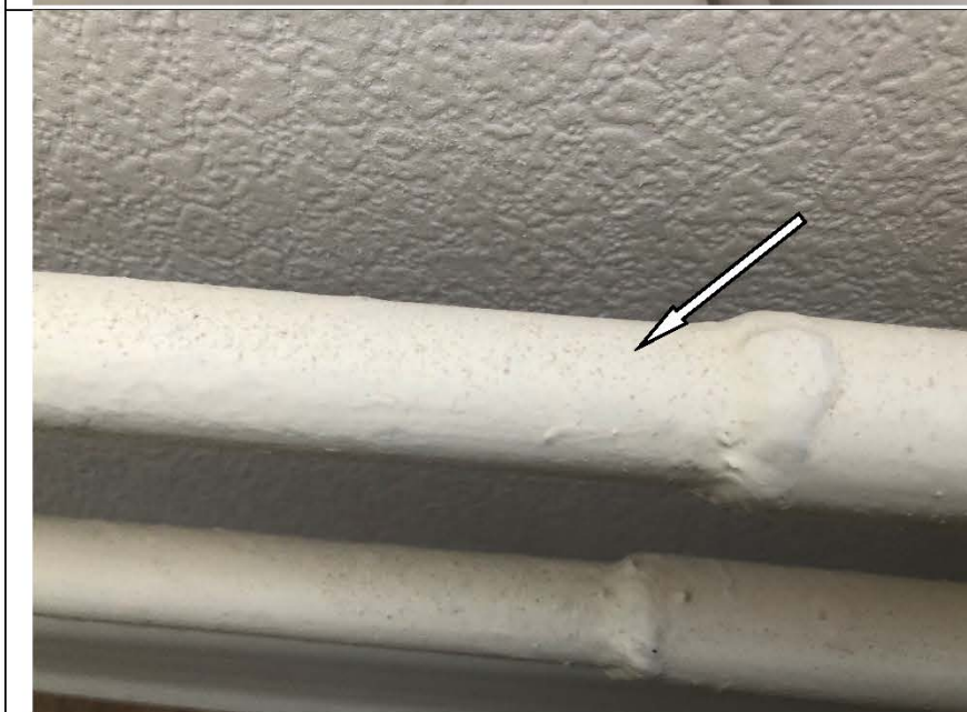
Фото №66. Неровности, сколы на окрашенных трубах отопления в детской в квартире.
