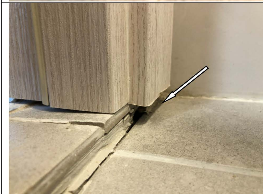
Фото №87. Наличник деревянного дверного блока не достает до напольного покрытия в санузле в квартире.
