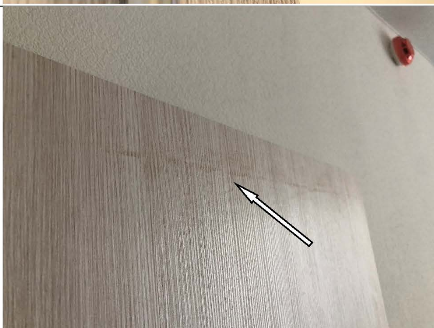
Фото №36. Загрязнения на полотне деревянного дверного блока в детской в квартире.
