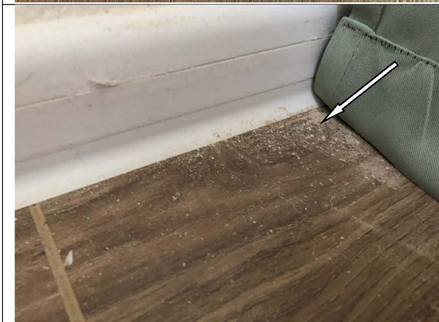
Фото №75. Загрязнения на ламинате в кухне в квартире.
