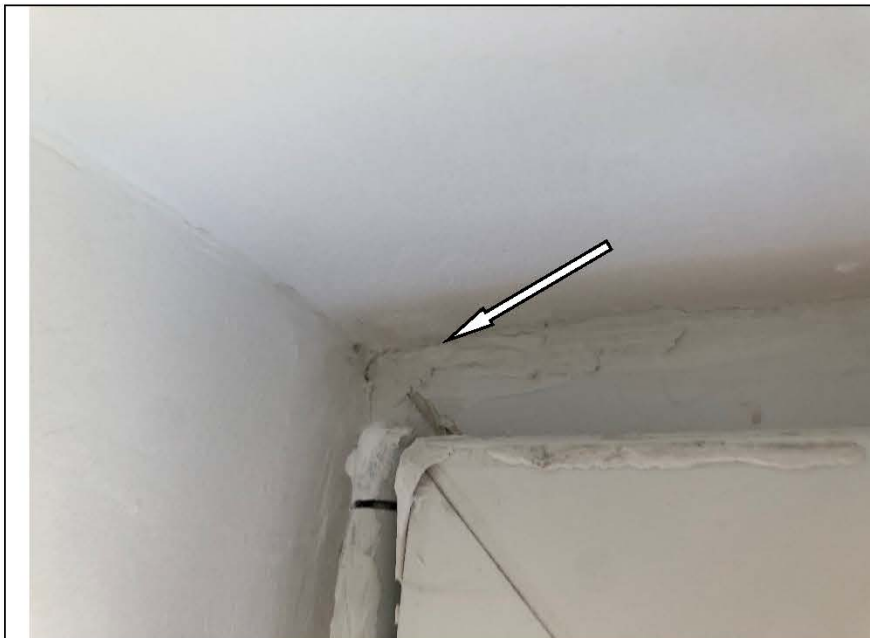
Фото №64. Инfiltrация оконного блока ПВХ в спальне в квартире.
