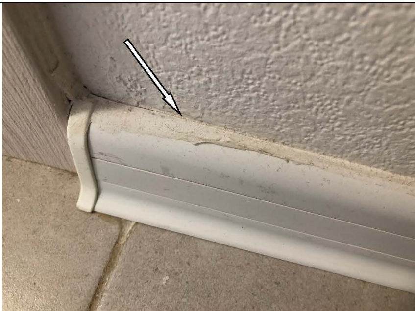
Фото №25. Загрязнения на напольном плинтусе ПВХ в коридоре в квартире.
