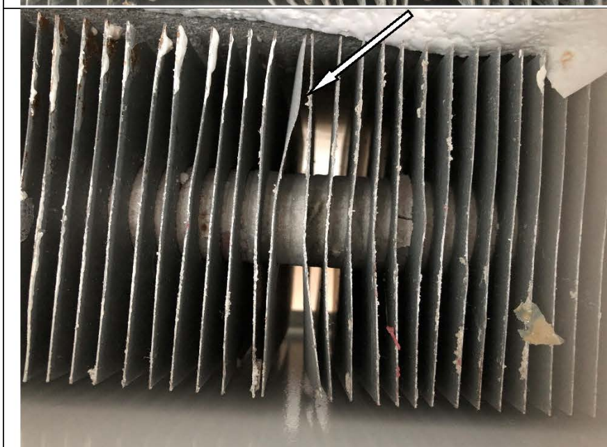
Фото №60. Замятие радиатора в спальне в квартире.
