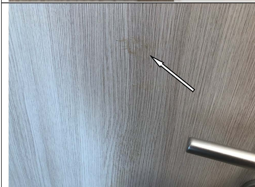
Фото №38. Загрязнения на полотне деревянного дверного блока в санузле в квартире.
