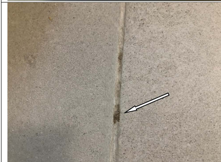
Фото №24. Неровный шов напольной керамической плитки в кухне в квартире.
