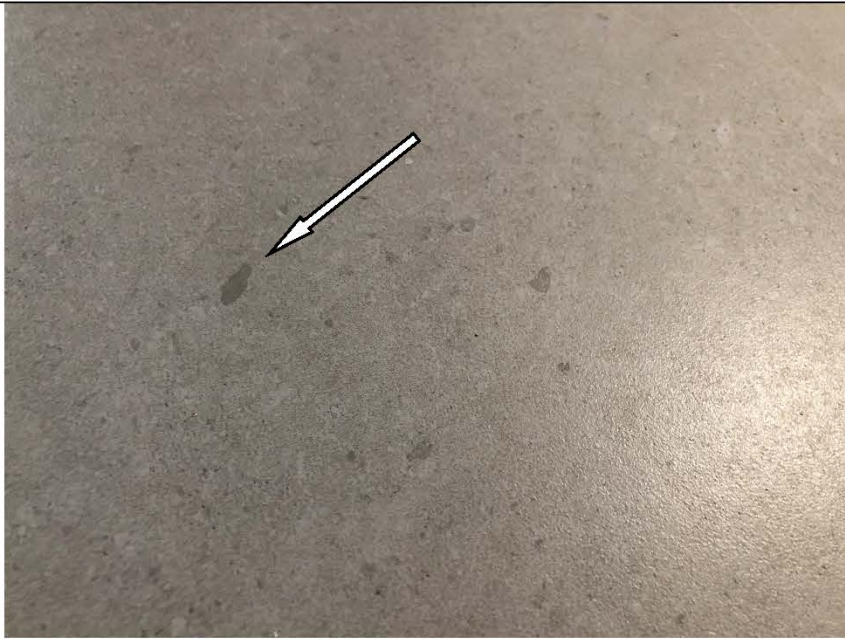
Фото №31. Загрязнения на напольной керамической плитке в кухне в квартире.
