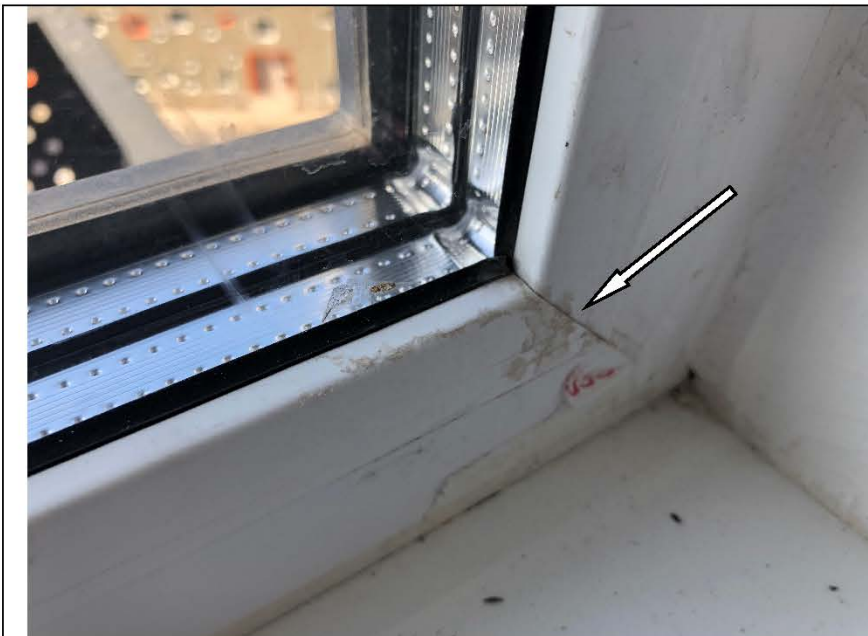
Фото №55. Загрязнения на профиле оконного блока ПВХ в кухне в квартире.
